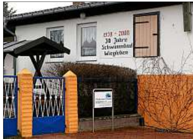
Die Sanierung der Sanitäranlagen im Freibad Wiegleben wird gefördert.
