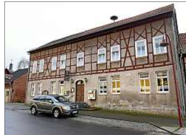
Der Umbau der Gemeindeschenke in Mehrstedt könnte schon im Mai beginnen.
