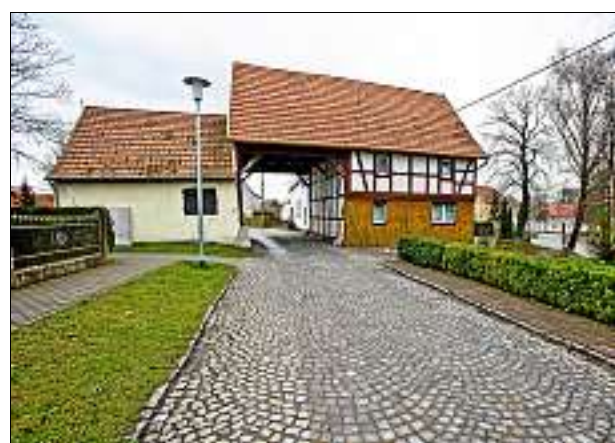
Dach und Sanitärbereich am Fickentor in Niederdorla müssen saniert werden.
