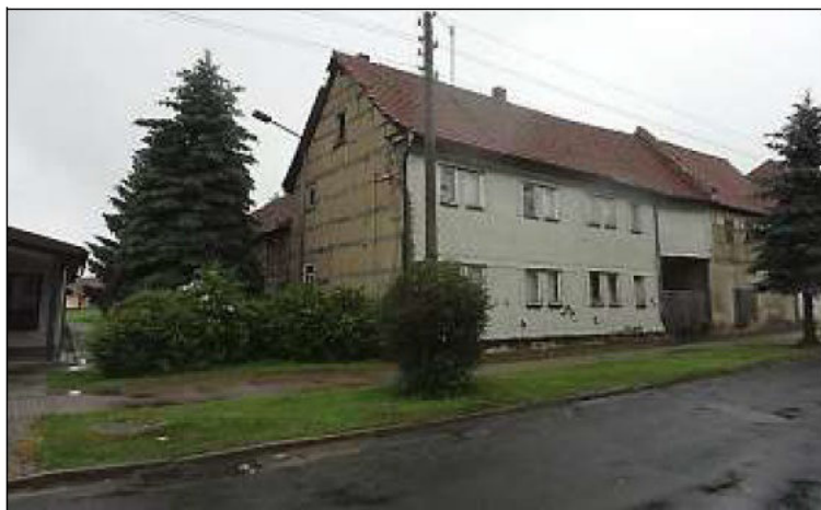
In Körner soll dieses alte Wohnhaus und ein Gehöft abgerissen werden. Dessen Eigentümerin war seit 20 Jahren nicht mehr vor Ort. Foto: privat
